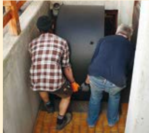
Abb. 3 links: Helfer tragen ein Speichermodul durch einen engen Zugang in den Keller, rechts: UniSto-Speicher mit Wärmedämmung aus silbergrauen Neopor®-Mantelschalen.
