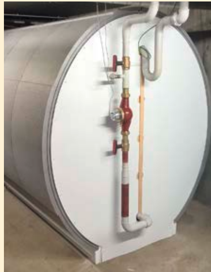
Abb. 3 links: Helfer tragen ein Speichermodul durch einen engen Zugang in den Keller, rechts: UniSto-Speicher mit Wärmedämmung aus silbergrauen Neopor®-Mantelschalen.
