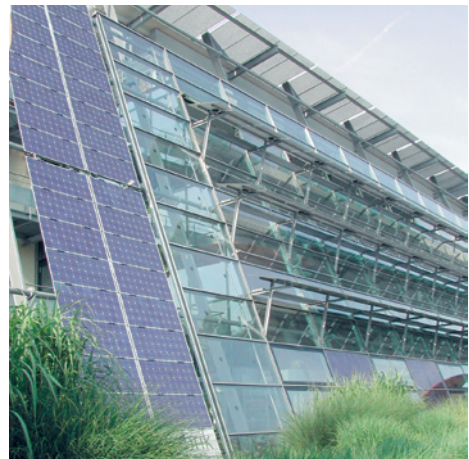
■ Abb. 6: Doppelglasmodule an der Solarfabrik in Freiburg
