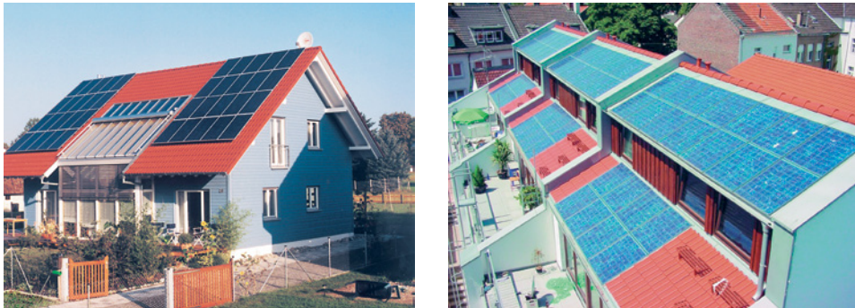
■ Abb. 2: Photovoltaik-Anlagen mit Auf-Dach-Montage (links), komplettes In-Dach-Montage-System (rechts)
