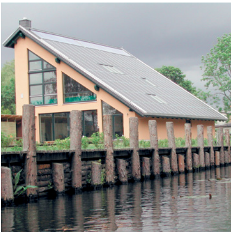
■ Abb. 5: Dachintegration von PV-Modulen und solarthermischen Kollektoren in Mirow
