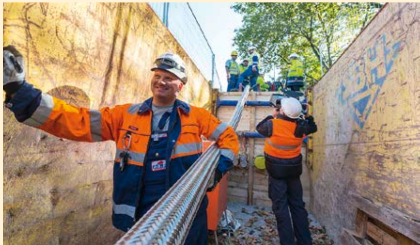
Abb. 2 Verlegung des Supraleiterkabels in der Essener Innenstadt
