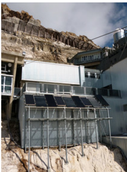
Die Nahaufnahme zeigt den Freibewitterungsteststand am Schneefernerhaus auf der Zugspitze. © Fraunhofer ISE
