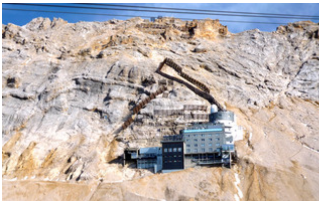
Alpiner Teststand: An der Umweltforschungsstation Schneefernerhaus sind vor dem linken Gebädetrakt die Test-Kollektoren aufgeständert. © Fraunhofer ISE
