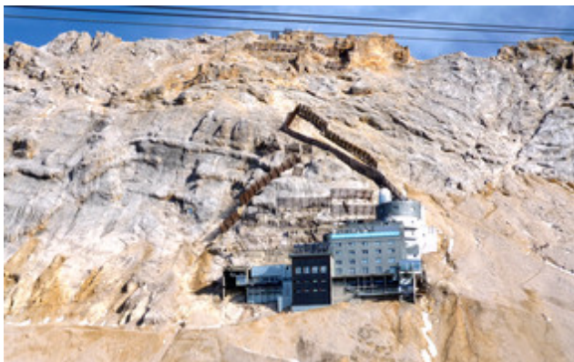
Alpiner Teststand: An der Umweltforschungsstation Schneefernerhaus sind vor dem linken Gebädetrakt die Test-Kollektoren aufgeständert. © Fraunhofer ISE
