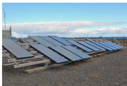
Maritimer Teststand in Meeresnähe: Die Abbildung zeigt das Kollektortestfeld bei Pozo Izquierdo auf Gran Canaria. © Fraunhofer ISE
