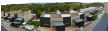
Ein Teil der Häuser in der Siedlung hat eine durchgehende Dachterrasse. Die Kollektoren sind fest mit der seitlich angepassten Wind- und Sichtschutzwand und der Dachterrasse verbunden und somit architektonisch eingepasst. © Harald Kicker, JKU Linz, Austria
