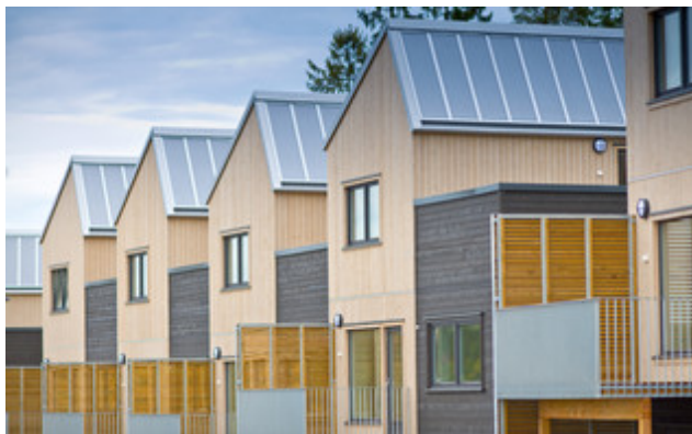
Reihenhausssiedlung Stenbråtlia in der Nähe von Oslo: 34 Reihenhäuser im Passivhausstandard wurden mit dachintegrierten Kunststoffkollektoren ausgestattet. © Harald Kicker, JKU Linz, Austria
