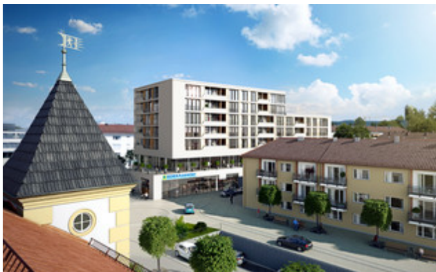
Das Puls G – ein Mischgebäude mit 13.000 m 2 Bruttogeschossfläche – bildet das Herz des Quartiers, der „Neuen Mitte“ von Geretsried. Hier begannen die Bauarbeiten im Sommer 2017. © Krämmel Wohn- und Gewerbebau GmbH
