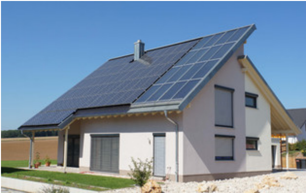
Bei optimaler Ausrichtung bietet ein Pultdach ausreichend Platz für eine großflächige Installation von Solarkollektoren und Photovoltaik-Modulen.
