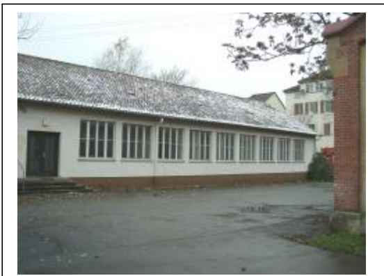
Abb. 1: Vor der Sanierung
