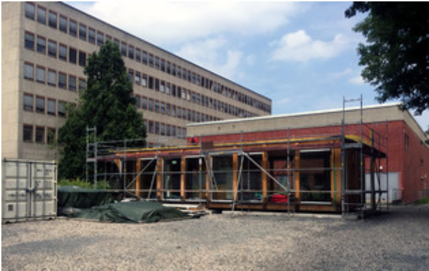
Für den Aufbau auf dem Campus wurden neue Seitenfassaden aus Holz entwickelt. © UdK Berlin / VPT
