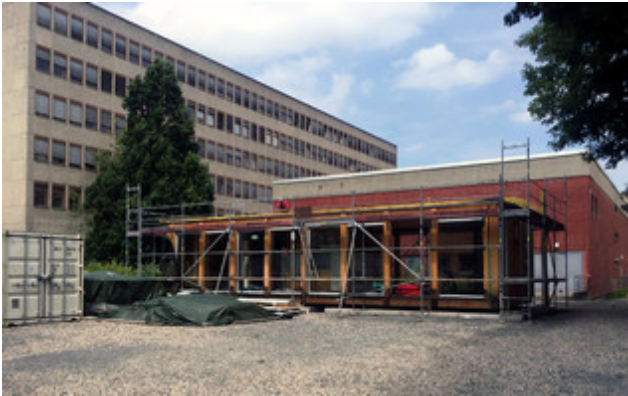
Für den Aufbau auf dem Campus wurden neue Seitenfassaden aus Holz entwickelt. © UdK Berlin / VPT
