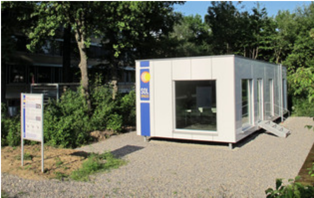
Im Projekt SolSpaces entwickelten Forscher ein Heizungskonzept mit saisonalem Sorptionswärmespeicher für das dafür angefertigte energieeffiziente 43 Quadratmeter große Forschungsgebäude (im Bild).
