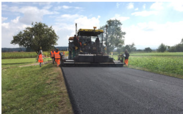
Die Landesstraße L 1206 nahe Filderstadt wird asphaltiert. Das SmartSite-System hat den Praxistest bestanden. © Drees & Sommer
