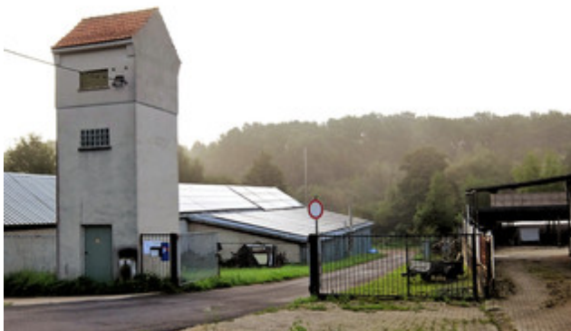
Ländliche Stromnetze optimal ausbauen © Dr. Franz Meyer, BINE Informationsdienst
