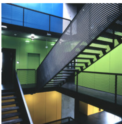
Rippenstreckmetall als tragendes Bauteil im Treppenbau © Stahl-Zentrum
