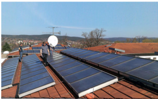
Vor Beginn des Monitorings begutachteten die Experten die Solaranlagen.
