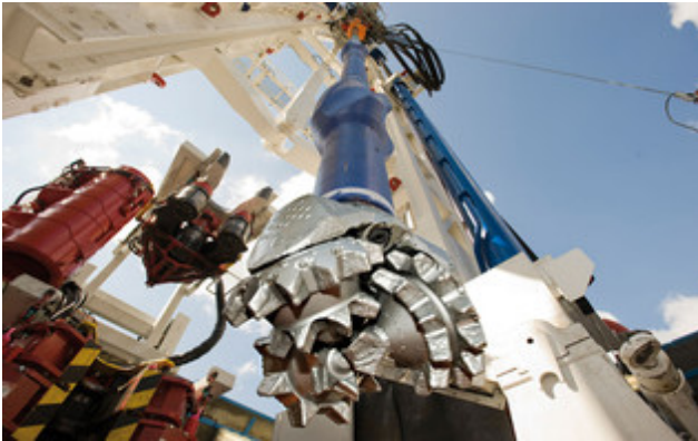
Auf dem Versuchsfeld Horstberg Z1 in der Nähe von Uelzen erprobt die BGR ein Konzept zur geothermischen Erschließung von Sedimentgesteinen im Norddeutschen Becken. © BGR (Symbolbild)
