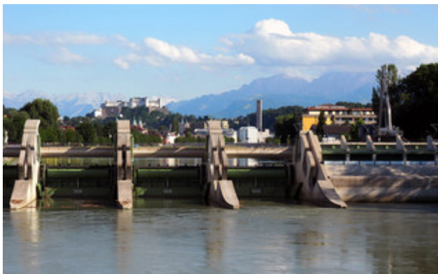
Anfang Juli 2017 fand in Salzburg das „5. Trinationale Austauschtreffen“ sowie ein Smart City Round Table statt. Das Salzburger Laufwasserkraftwerk war eines der Exkursionsziele. © DACH-Projekt
