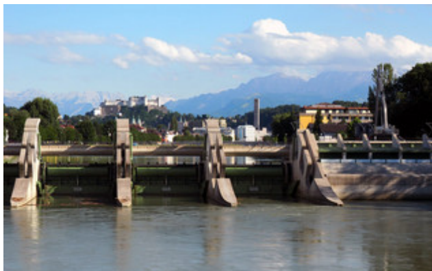
Anfang Juli 2017 fand in Salzburg das „5. Trinationale Austauschtreffen“ sowie ein Smart City Round Table statt. Das Salzburger Laufwasserkraftwerk war eines der Exkursionsziele. © DACH-Projekt
