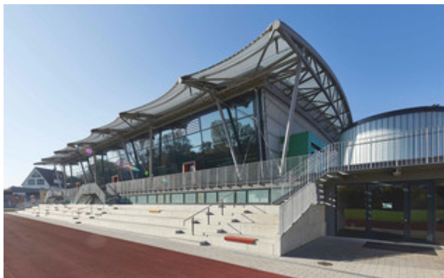
Außenansicht des Julius Hirsch Sportzentrums in Fürth © fab_Architekten / Ben Van Skyhawk
