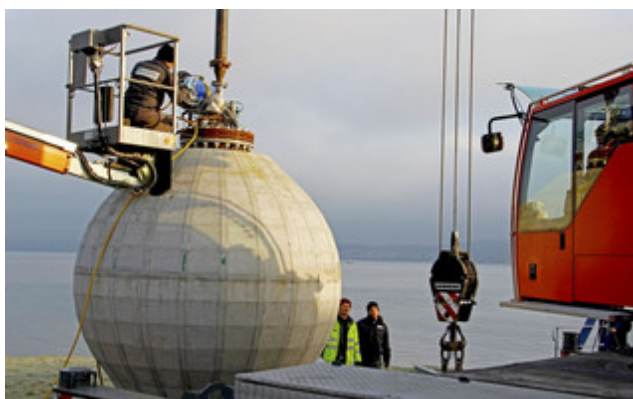
Prototyp für Test: Die Beton-Hohlkugel wurde im Maßstab 1:10 gefertigt und hat einen Durchmesser von drei Metern. © Fraunhofer IWES / Energiesystemtechnik
