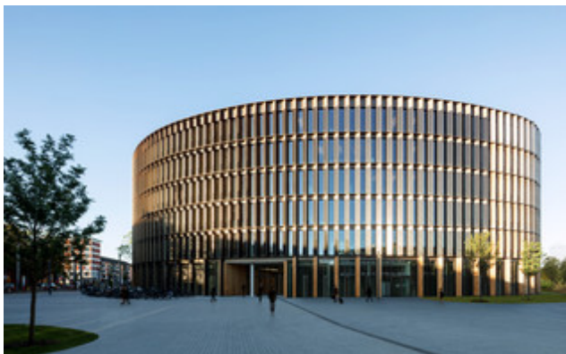
Der Neubau bringt die Gemeindeverwaltung an einem Standort zusammen.
