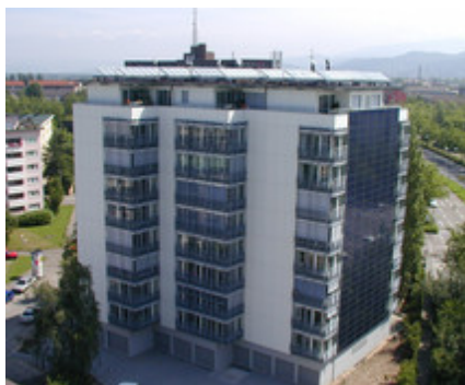
Wohngebäude der Familienheim Freiburg Baugenossenschaft in der Wilmersdorfer Straße mit auf dem Dach aufgeständerten Flachkollektoren und PV-Fassade © Bollin, FH Offenburg
