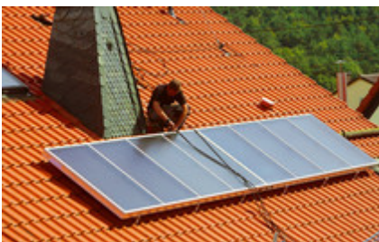
Ein Handwerker installiert einen Kollektor auf dem Dach. Mit vereinfachten Montagesystemen wäre es auch für Dachdecker oder Fensterbauer möglich, die Anlagen anzubringen. © Solvis
