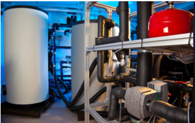
Wissenschaftler modellieren im Projekt TeWiSoL detailgenau Schlüsselkomponenten, wie etwa hier abgebildete solare Wärmespeicher. © Fraunhofer ISE
