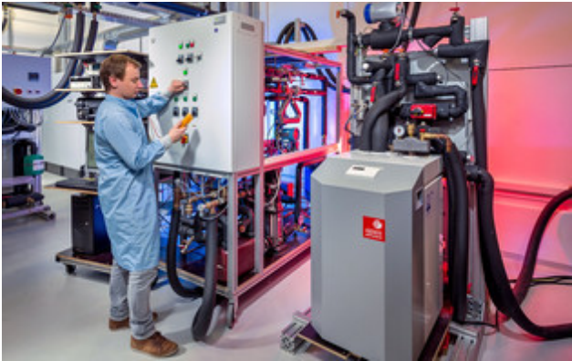
Experimental-Anlage zum Betrieb einer Wärmepumpe mit Niedertemperaturwärme aus oberflächennaher Erdreichwärme und Solarkollektoren. Solare Wärme hilft den Flächenbedarf von Erdwärmekollektoren deutlich zu verringern und macht diese Systeme damit attraktiver.
