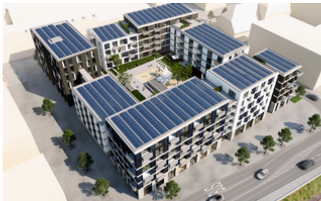
Bèla ist der erste von sechs Wohn-/ Gewerbeblöcken in der neuen Weststadt Esslingen. Die drei Gebäude verfügen über 132 Wohneinheiten. Die Dachbelegung mit einer Photovoltaikanlage von ca. 250 kWp ermöglicht die Nutzung erneuerbarer Energien, die über ein Mieterstrommodell vermarktet werden. © Graf und Graf Architekten
