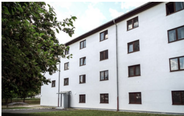
Die Südansicht des Demonstrationsgebäudes, ein mehrgeschossiges Wohngebäude im INNOPARK Kitzingen. Ein Teil der Fassade wird mit multifunktionalen Fassadenelementen belegt, um deren Funktion unter realen Bedingungen zu erproben.
