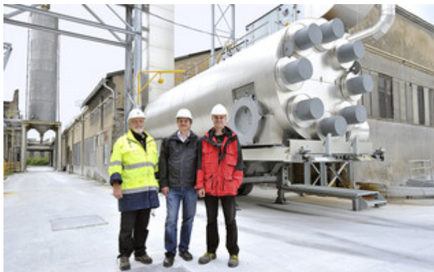
Die Projektleiter an der Entladestation bei Jäckering (v. l.): Burghard Kinzel von Hoffmeier, Martin Treder von der Müllverbrennungsanlage Hamm und Andreas Krönauer vom ZAE Bayern. © MVA Hamm
