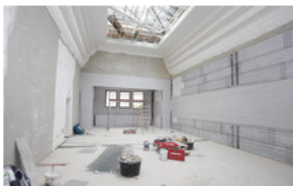
In den Oberlichtsälen wurden die provisorischen Holzdecken entfernt und eine Wandheizung installiert.
