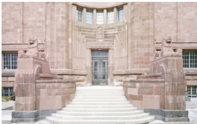
Die energieeffiziente Sanierung des denkmalgeschützten Museums hat Vorbildcharakter.
