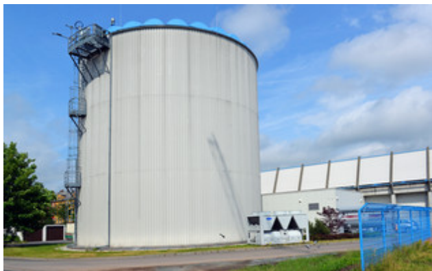
Der erfolgreiche Kältespeicher in Chemnitz wurde in Segmentbauweise errichtet. Die dabei gesammelten positiven Erfahrungen sollen jetzt auch für neue Wärmespeicher in ähnlicher Bauweise genutzt werden. © PD Dr. Thorsten Urbaneck
