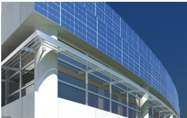
Die Integration von Photovoltaik in die Gebäudehülle ist weltweit ungebrochen auf dem Vormarsch. © arsdigital | Fotolia.com
