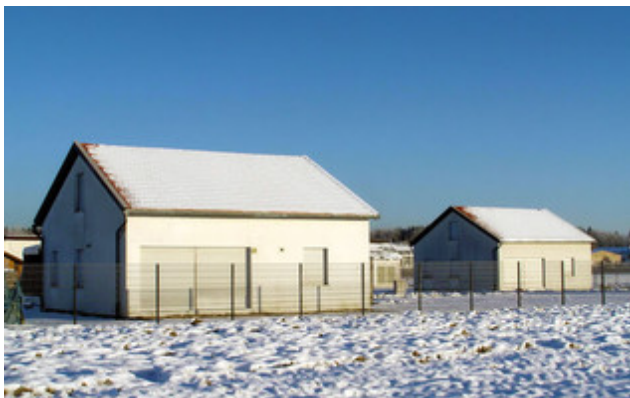
Die Vergleichsmessungen während einer Heizperiode erfolgten in zwei baugleichen, unbewohnten Einfamilienhäusern auf dem Versuchsgelände des IBP in Holzkirchen.
