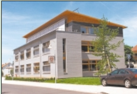
Das Bürohaus des Ingenieur- und Vermessungsbüro Hans Lamparter GBR in Weilheim a.d. Teck ist das erste Passiv-Bürohaus Europas (links) und nutzt freie Nachlüftung zur passiven Kühlung im Sommer (rechts). Quelle: Architektur: Architekten Werkgemeinschaft Maier, Weinbrenner, Single (Nürtingen), Energiekonzept: Fraunhofer ISE (Freiburg), Monitoring: Fachhochschule für Technik, Fachbereich Bauphysik (Stuttgart).
