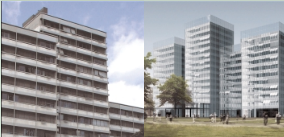
24 KfW-Hochhaus heute und die Sanierung als Visualisierung. Quelle: Architektur: RKW Architekten, Energiekonzept: Ingenieurpartnerschaft ip5, Monitoring: Universität Karlsruhe.
