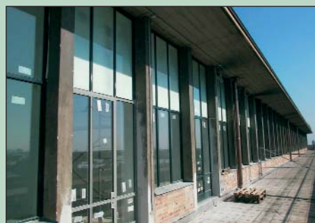
Außenansicht der Pilotfassade während der Aufbauphase. Die thermotrope Verglasung im Oberlichtbereich ist in den bestrahlten Bereichen weiß geschaltet.
