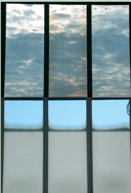
Detailansicht eines mit thermotroper Verglasung ausgestatteten Oberlichtes: a) im ungeschalteten Zustand (mittlere Scheibe: Schaltungsvorgang beginnt gerade), b) im geschalteten Zustand. Schaltung nur in den direkt bestrahlten Bereichen.
