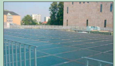
Das Dach über dem zentralen Lesesaal der sächsischen Landesbibliothek Dresden, ausgeführt als begehbare Überkopfverglasung.
