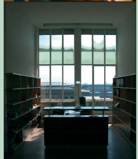
Innenansicht eines Büroraumes, im Oberlichtbereich die thermotrope Verglasung: a) bei eben einsetzender Schaltung, b) im geschalteten Zustand. Die Verglasung schaltet nur in den direkt bestrahlten Bereichen. Dadurch wird das direkte Sonnenlicht in diesem Bereich effektiv reflektiert.
