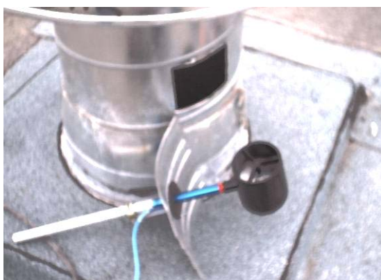
Bild 8: Einbau eines Flügelrades in die zentrale Abluftöffnung auf dem Dach des Südgebäudes
