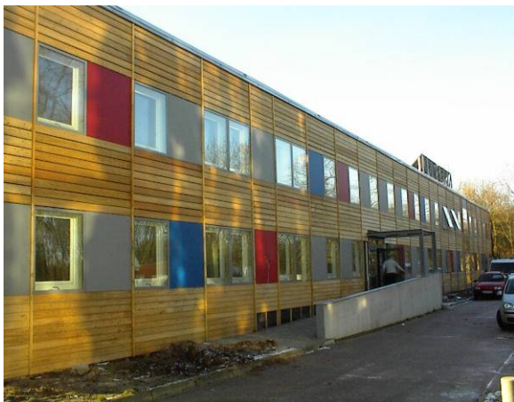
Bild 3: Nordansicht des Gebäudes nach der Sanierung
