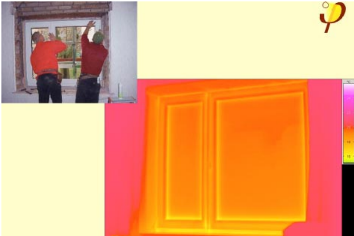
Abb. 8: Ausführungsfoto vom Einbau und Innenthermographie des annähernd wärmebrückenfrei eingebauten Fensters.
