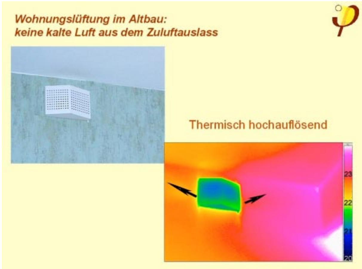
Abb. 24: Zuluft einlass mit thermographischer Aufnahme bei extrem hoher Temperaturlöschung; die Ausbreitung des Luftstrahls an der Decke ist zu erkennen
