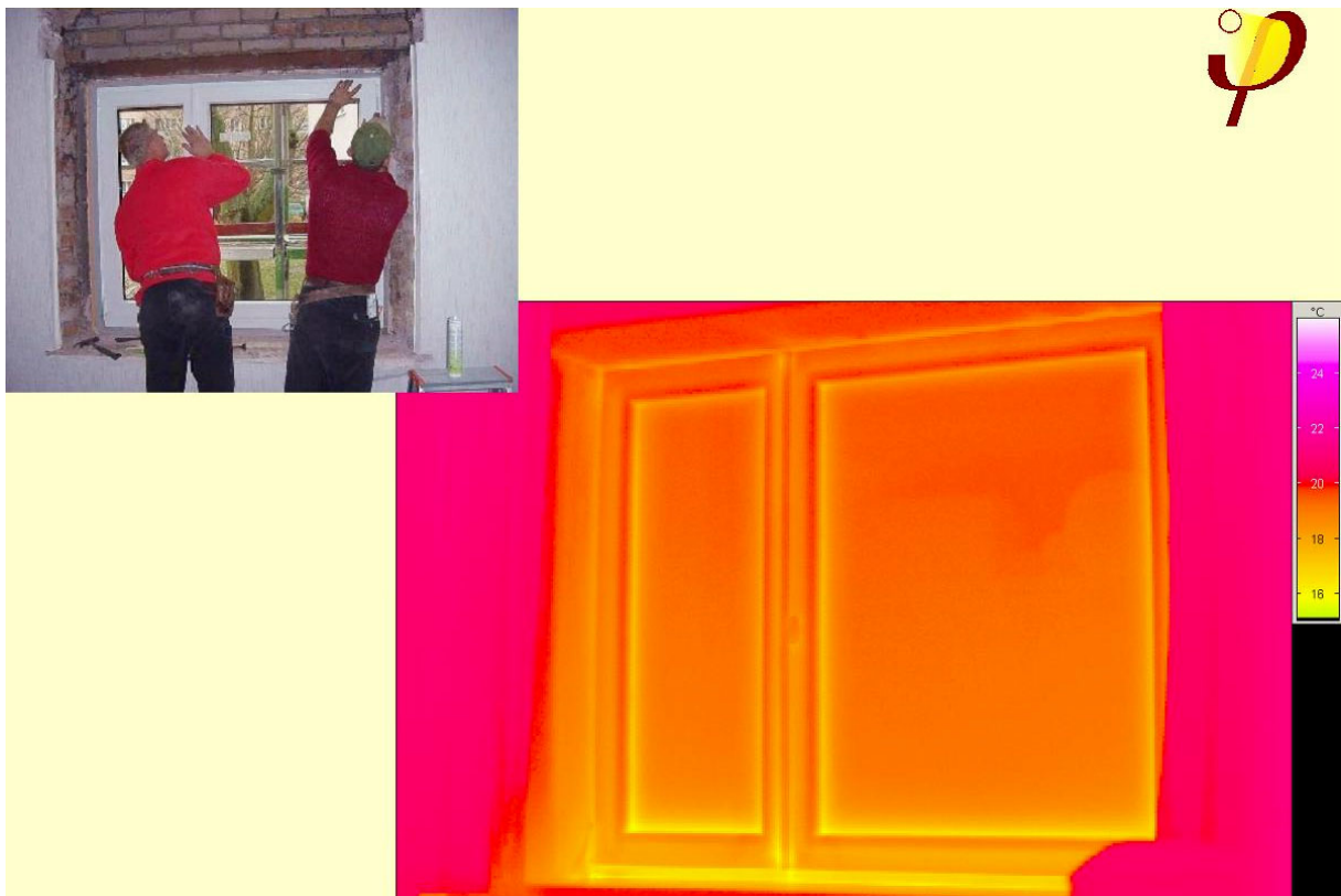
Abb. 3: Ausführungsfoto vom Einbau und Innenthermographie des annähernd wärmebrückenfrei eingebauten Fensters.
