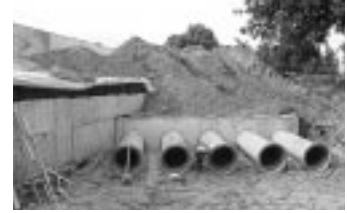
Bild 8: Der Erdkanal in Bau
