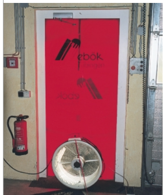
Blower-Door zur Messung der Undichtigkeit der Bauhülle.
