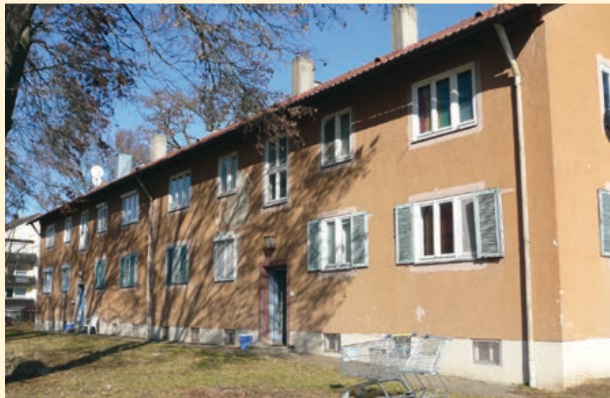
Abb. 3 Neben dichter Hochhausbebauung sind sanierungsbedürftige Gebäuderiegel typisch für das Quartier Grünbühl.
