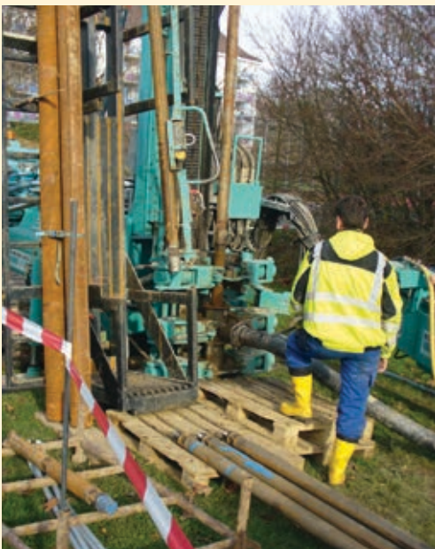
Abb. 5 Verlegung von Erdsonden unter einer Freifläche im Gebiet Sonnenberg-Südwest.
