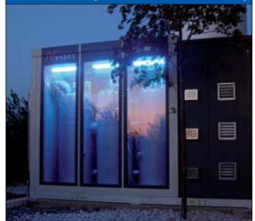
Abb. 7: Strombegrenzer im Kraftwerk Boxberg
