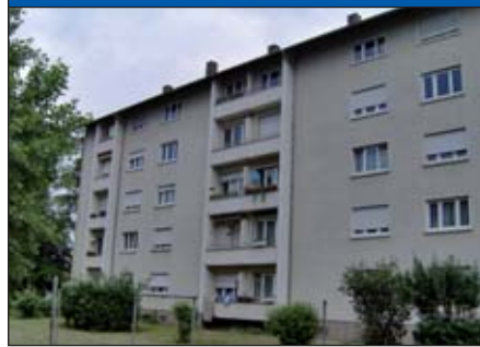
Abb. 4: Typisches Riegelgebäude im Ausgangszustand
