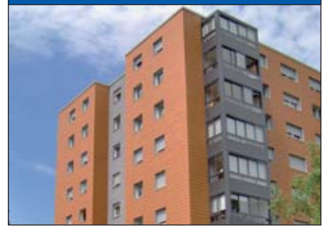
Abb. 5: Eines der Wohnhochhäuser nach der Sanierung
