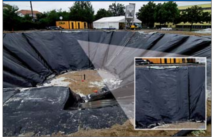
Abb. 5: Die Sekundärtasche entsteht durch das Aufschweißen einer Verbindungsfolie von einer Primärtasche zur nächsten.
