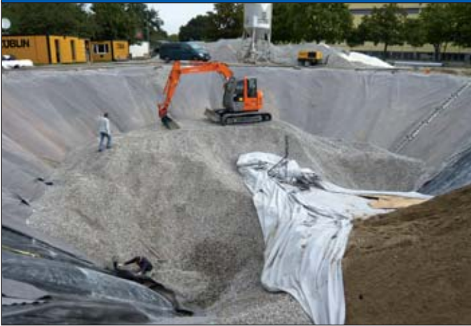
Abb. 4: Kiesbefüllung des Speichers
