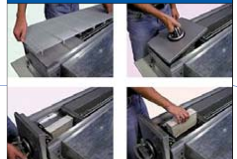
Abb. 5: Filterwechsel bei einem Fassadenlüftungsgerät
