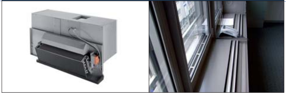
Abb. 2: Fassadenlüftungsgeräte: Links: Brüstungsgerät; rechts: eingebaute Brüstungsgeräte im Bürogebäude des Siedlungswerks in Stuttgart
