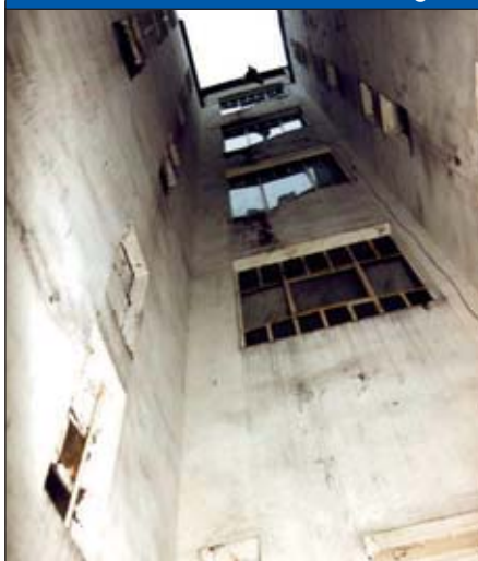
Abb. 3: Lichtschacht vor der Sanierung
