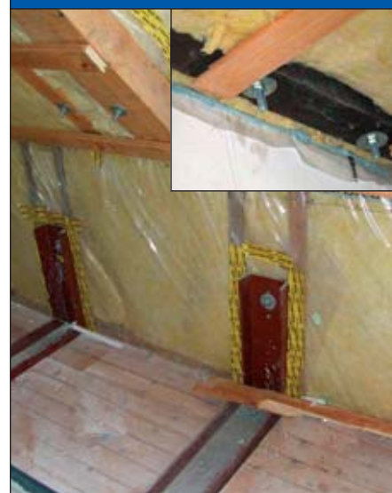
Abb. 8: Luftdichtung der Decke und der Gaubenwand
