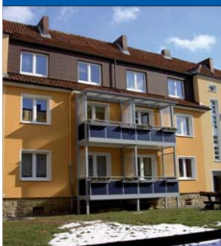
Abb 5: Gebäude Wiershäuser Weg 35-41 in saniertem Zustand
