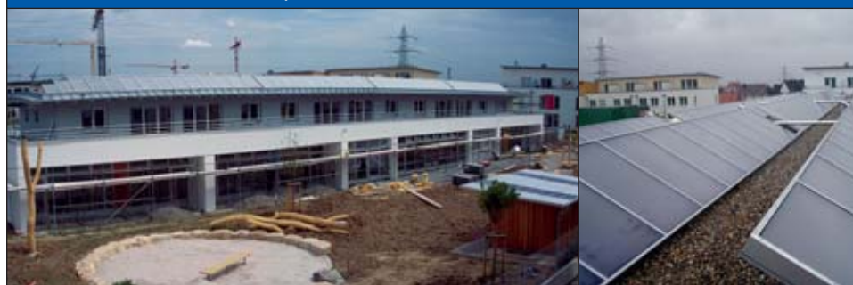
Abb 7: Südansicht Kinderhaus, Kollektorfeld
