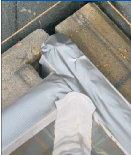
Abb 5: Ecklösung mit durchgehender VIP-Dämmebene
