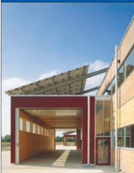
Abb 4: Die Tore der Vorbauten für die Warenanlieferung sind in der Regel nie gleichzeitig geöffnet
