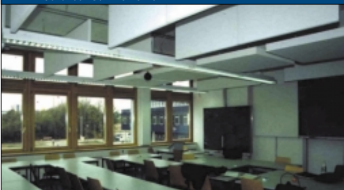
Abb 4 Seminarräume mit TWD-Oberlichtern, Leuchtbändern und Schallschluck-Elementen
