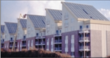
Abb 8 1000 m 2 Solar Roof; Nord-Süd-orientiertes Mehrfamiliengebäude (Rostock)
