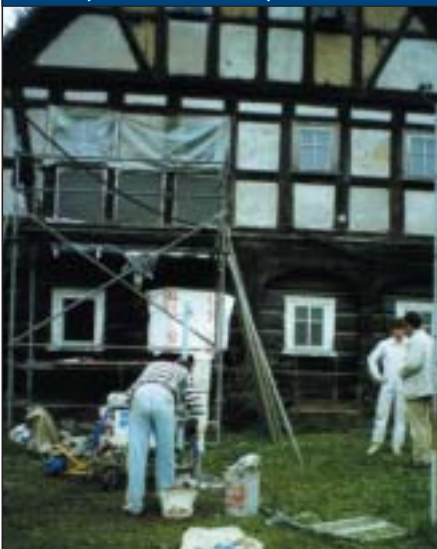
Abb. 5 Substitution der Strohlehmausfachung (Quelle: TU Dresden)
