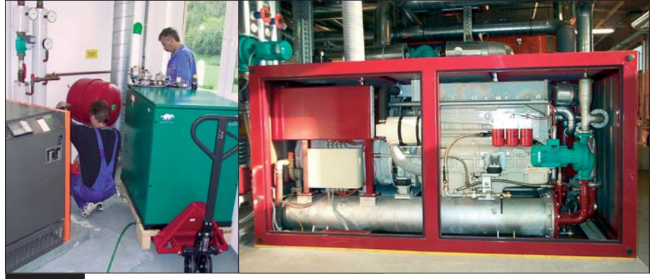
Abb. 5 Links ein Mini-BHKW mit 5,5 kW el . Rechts ein größeres Aggregat aus dem Leistungsbereich 50 – 120 kW el [Quellen: Senertec, communa metall]
