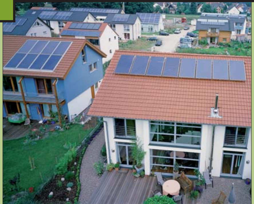
Abb. 1 Sonnenkollektoren für die Wärmeerzeugung (Solarthermie) (Quelle: BSW-Solar)
